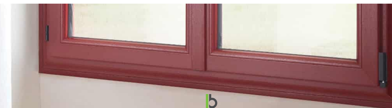
Paumelle standard à gauche et paumelle oscillo-battante à droite
