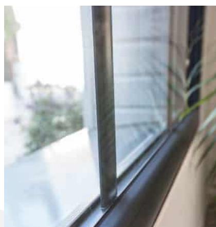
Petits-bois alu 45 x 8 mm intégrés au vitrage
